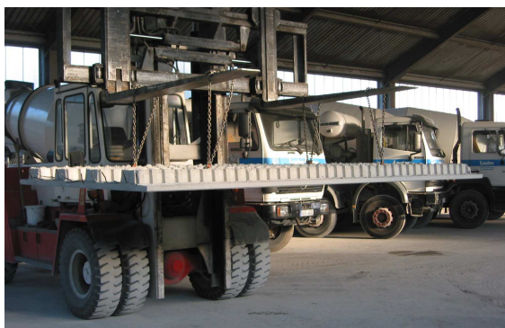
Bild 12: Transport einer Stegverbundplatte
