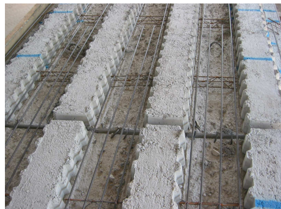
Bild 4: Bewehrungsführung bei Durchlaufwirkung
